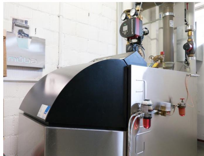
Die neue Heizung
